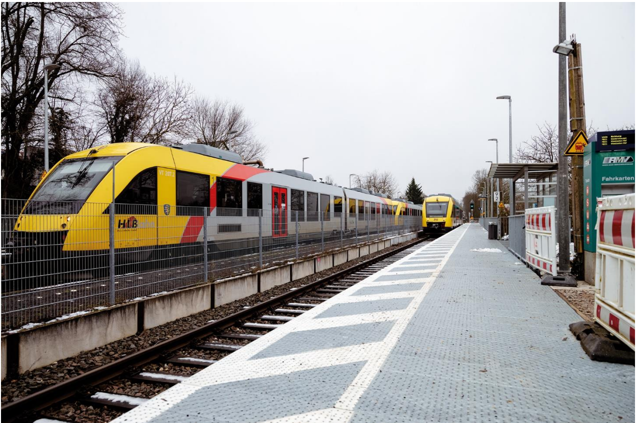
Bild 1: Provisorium Kreuzungsbahnhof Wiesbaden-Igstadt, aufgenommen am 24. Januar 2023
