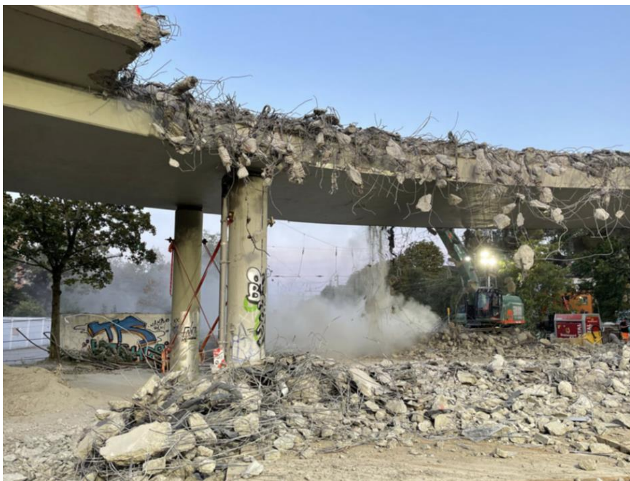
Abbildung 2: Griesheimer Omega-Brücke zu Beginn der Abrissarbeiten
