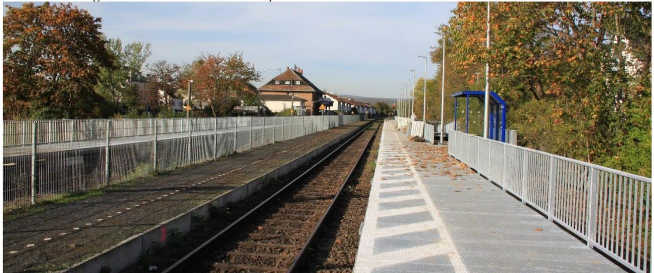
Bild 26: Eine Meisterleistung von DB Station&Service, die Herstellung der beiden provisorischen Außenbahnsteigen in Igstadt in einer Woche. Es fehlen nur noch die Beschilderung, die H-Tafeln, die Fahrgastinfo und die RMV-Automaten.
