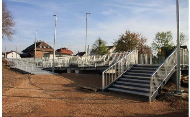
Bild 23: Erstmals gibt es einen barrierefreien Zugang von der Bornstraße n u r zum Gleis 2 und über acht Stufen
