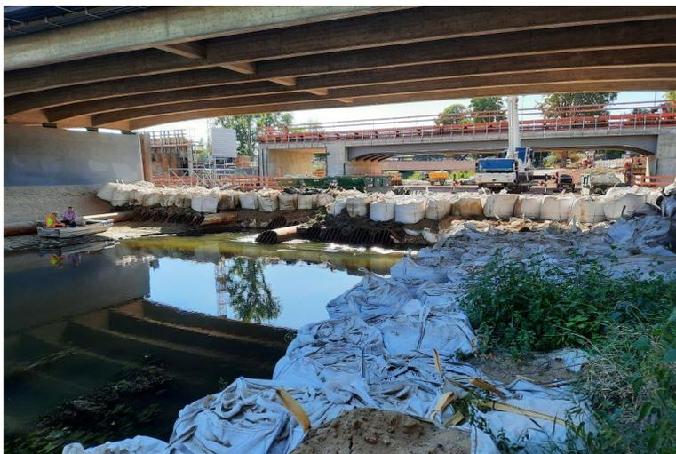
Das Flussbett der „trockengelegten Nidda, im Hintergrund die neue Bahnbrücke, vorn die Brücke der Frankfurter Straße in Bad Vilbel. Metallrohe sollen auch die Wassermenge bei Starkregen auffangen können. Nach Ende der Bauarbeiten wird alles wieder zurückgebaut.
