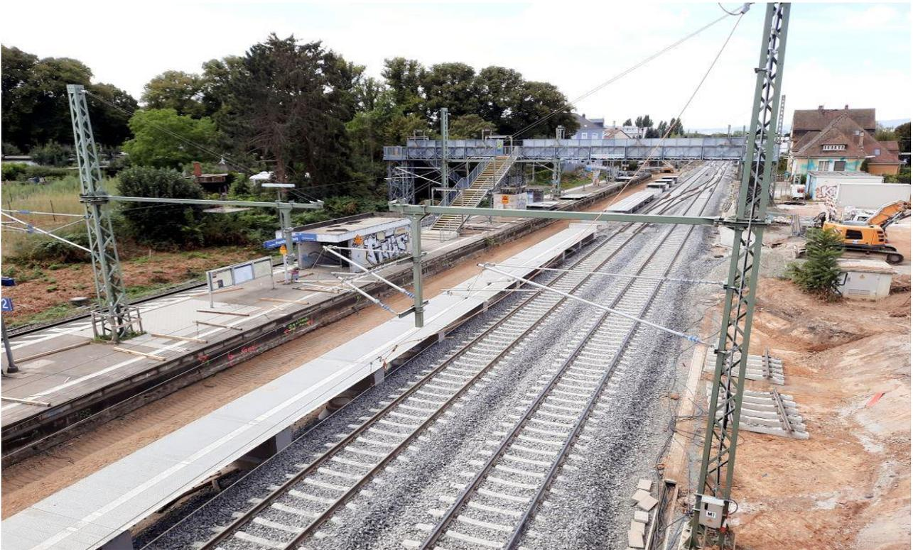
Die Station Frankfurter Berg am 21.08.2022: Der alte Bahnsteig für Gleis 2 und 3 ist noch vorhanden. Im Vordergrund befindet sich der provisorische Bahnsteig in Fahrtrichtung Friedberg mit den Gleisen auf der neuen Bahntrasse. Im Hintergrund die provisorische Fußgängerüberführung.
