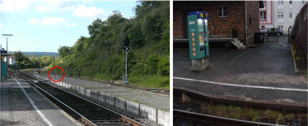
Bild 3 (links): Bisher sicherte der örtliche Fahrdienstleiter (Fdl) den Reisendenüberweg zum (verkappten) Mittelbahnsteig des Gleises 2 durch eine Kette (roter Kreis) bzw. bei Zugkreuzungen nach Durchfahrt des Zuges auf Gleis 1 nach Entfernen derselben. Noch gut zu erkennen die alte Seilzugtechnik für die Signale und Weichen und die längst gekappten Telegrafentelegraphenleitungen. Bild 4: Im Grundbuch verbrieft Zugang zu den Gleisen für DB Netze, DB Station & Service und Arcor AG, Frankfurt.
