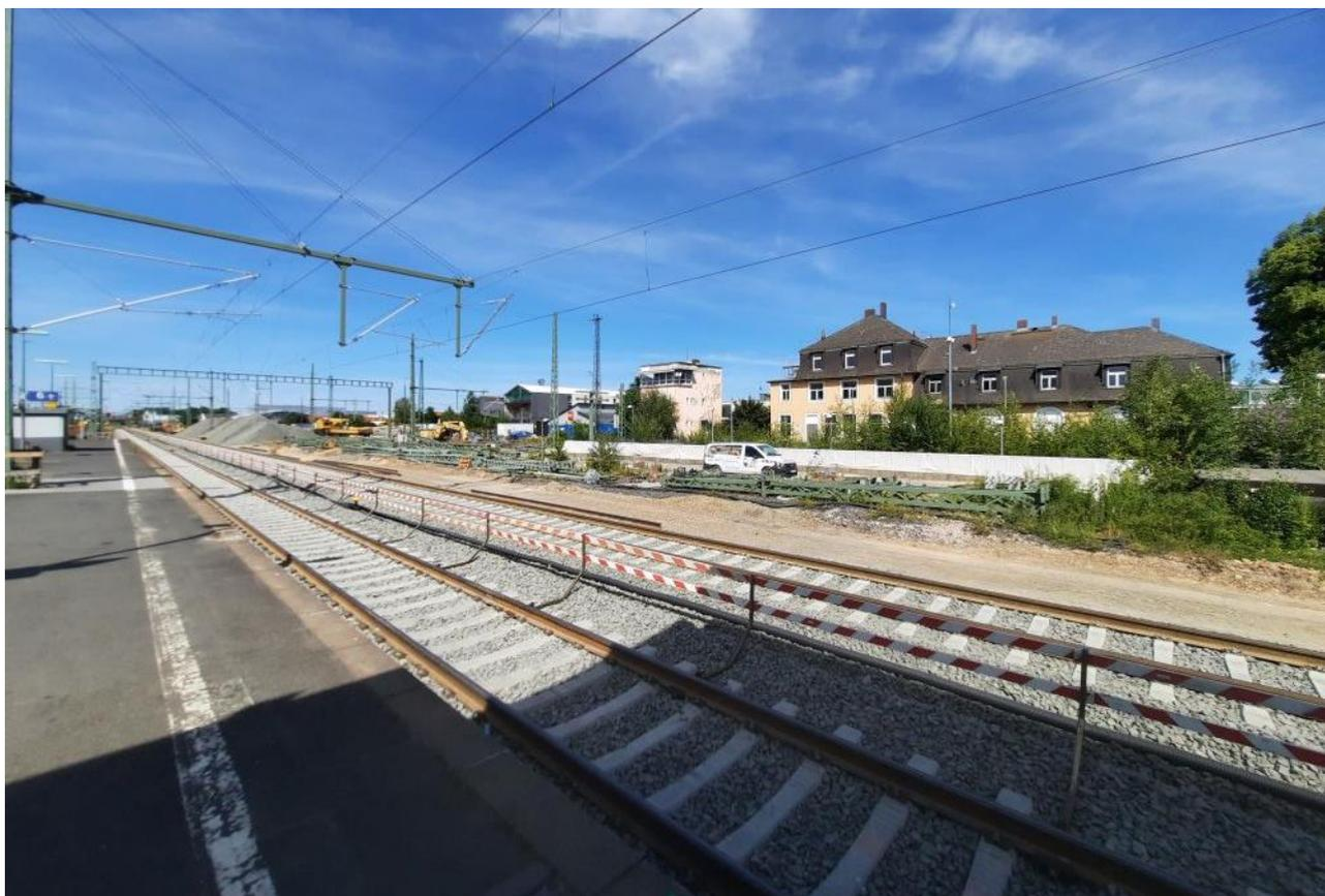
*Das Bahnareal von Bad Vilbel in Blickrichtung des derzeit verwahrlosten alten Bahnhofsgebäudes sowie des Stellwerks. Man kann erkennen, dass im Tiefbau die Flächen komplett neu mit dem Unterbau hergerichtet werden, um später darauf wieder Gleisanlagen zu errichten. Vorn das Gleis 5, daneben schon das neue Gleis 4, welches ohne Bahnsteigkante bleiben wird.*
