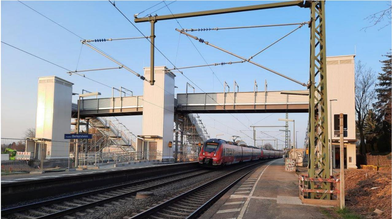
*Die provisorische Brückenkonstruktion mit drei Aufzügen an der Station Frankfurt-Berkersheim entstand bereits einige Zeit vor der Streckensperrung im Sommer 2022, weil der schienengleiche Bahnübergang bereits weit vorher geschlossen werden musste. Die Aufnahme entstand am 24.03.2022.*
