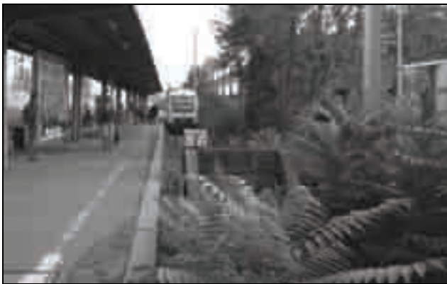
Gleiskopf Gleis 1 kann um 40 Meter zurückgenommen werden.
