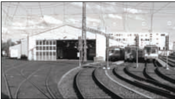
Im Oberurseler Stadtteil Bommersheim hat die U-Bahn ein kleines Depot. (Foto: Horst Honig)
