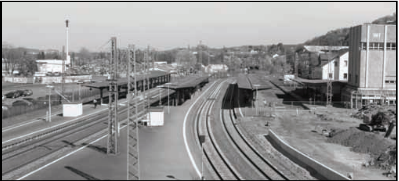
Bahnhof Wetzlar, rechts im Bild die Busbahnhof-Baustelle. (Foto: Thomas Kraft)
