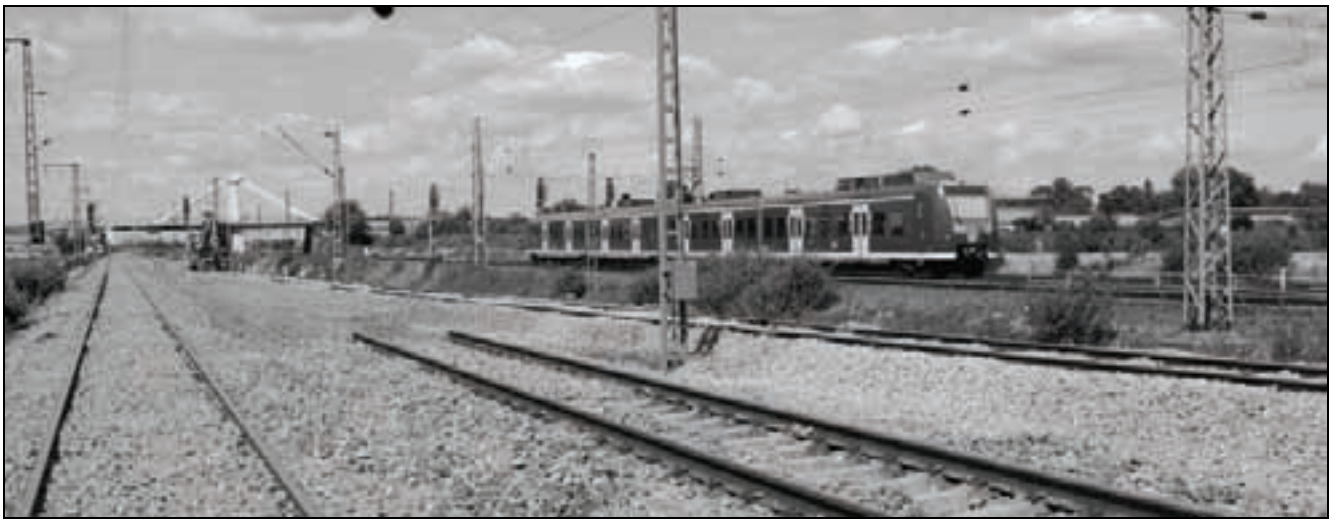
Bauarbeiten und Gleisverschwenkungen für ein neues Überführungsbauwerk zwischen Mannheim und Heidelberg. (Fotos: Klaus Rothenhöfer)
