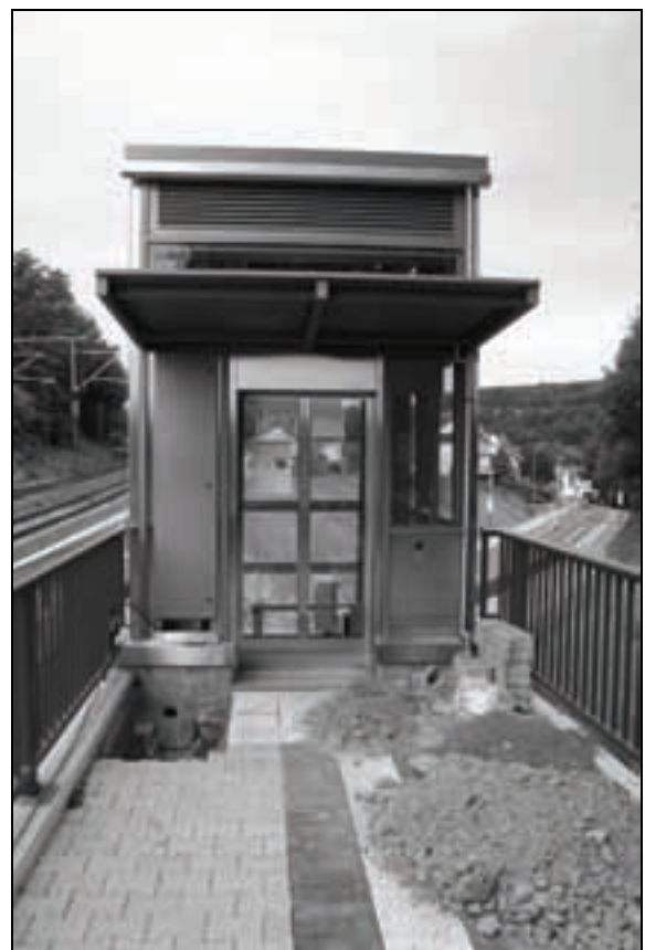
Der Aufzug in Niederjosbach
