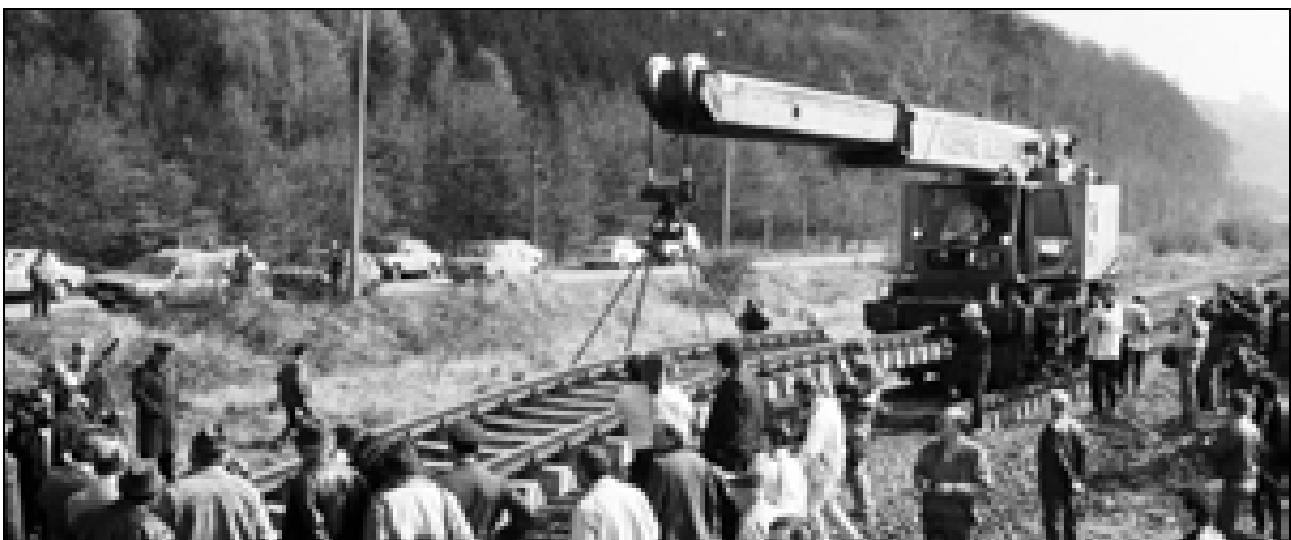
Wiederaufbau der Strecke in Herleshausen (Foto: Bundesarchiv)
