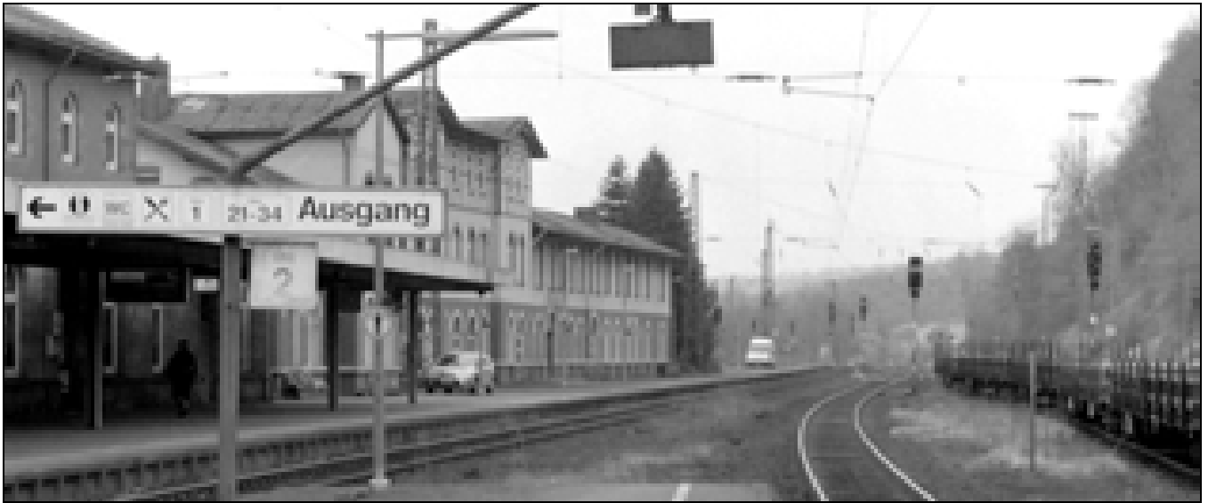
Altenbeken an der Mitte-Deutschland-Verbindung (Foto: Rainer Engelhardt)
