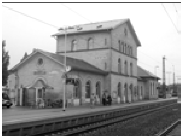
Bahnhof Dieburg an der Strecke nach Aschaffenburg. (Foto: R. Dietrich)
