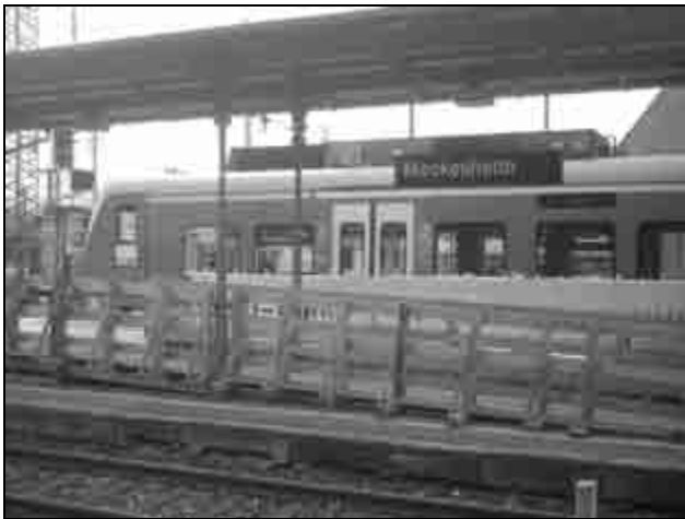
Noch eine Baustelle ist der S-Bahnhof Meckesheim. Wegen des strengen Winters haben sich auch die Bauarbeiten an der Station verzögert. (Foto: wb)
