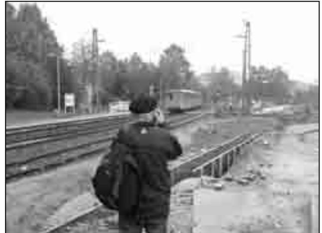
Bauarbeiten am Gleisdreieck U1/U3/U9 an der Station Hedderheimer Landstraße. Links ist die alte Kurve der U1 zu sehen, rechts die neue Kurve. Im Vordergrund ist der neue Bahnsteig Richtung Südbahnhof im Bau (Alle Fotos: hl, 10.10.2009).
