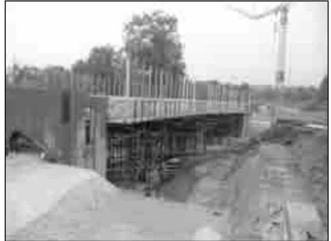
*Brücke über die Rosa-Luxemburg-Straße im Bau. Die Holzkonstruktion ist die Halterung der Schalung für den Spannbeton.*
