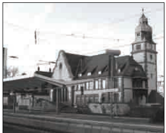
Bahnhof Bad Homburg – Endpunkt der Buslinie 261.
