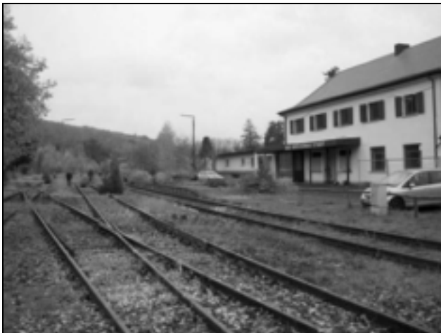
Bahnhof Bad Brückenau Stadt - Freischneideaktion der AG zeigt guten Zustand der Infrastruktur unter dem Bewuchs. (Foto: PRO BAHN Unterfranken/Corner)
