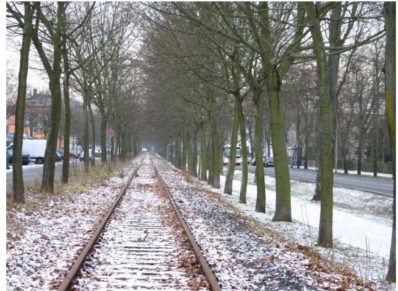
Freigehaltene Trasse an der Carl-Ulrich-Straße in Neu-Isenburg
