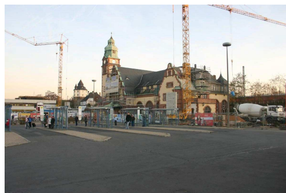
Baustelle Bad Homburg Bahnhof und Busbahnhof
