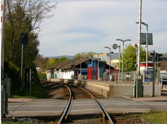
*F-Unterliederbach wird zum Kreuzungsbahnhof mit Mittelbahnsteig. Umstieg von der K-Bahn aus Königstein in den MTZ-Shuttle innerhalb 20 Sekunden*
