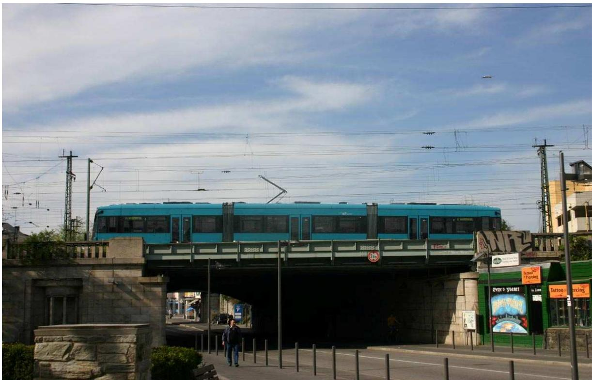
Fotomontage. Die Straßenbahn fährt auf eigenem Gleis und unter eigenem Fahrdrabt über das 1. Brückensegment in den Bahnhof Höchst, die S-Bahn wird über das stillgelegte 3. Brückensegment verschwenkt.
