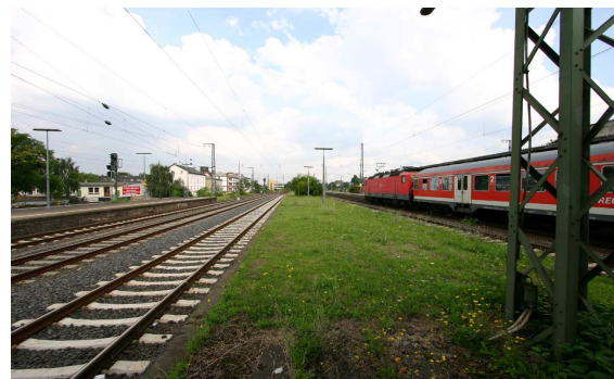
Derzeit nur Platzhalter für die RTW: Bahnsteiglose Gleise 7 und 8 (Foto: Wilfried Staub)
