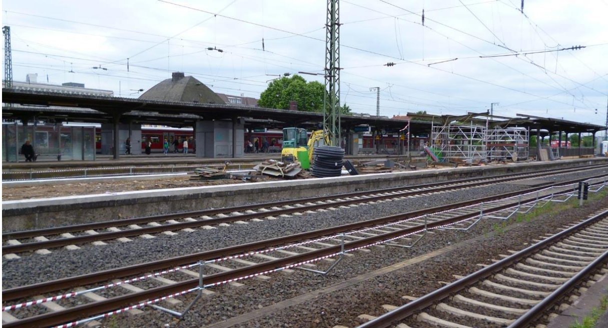
Reaktivierung Bahnsteig 4 für die Dauer der Umbaumaßnahme
